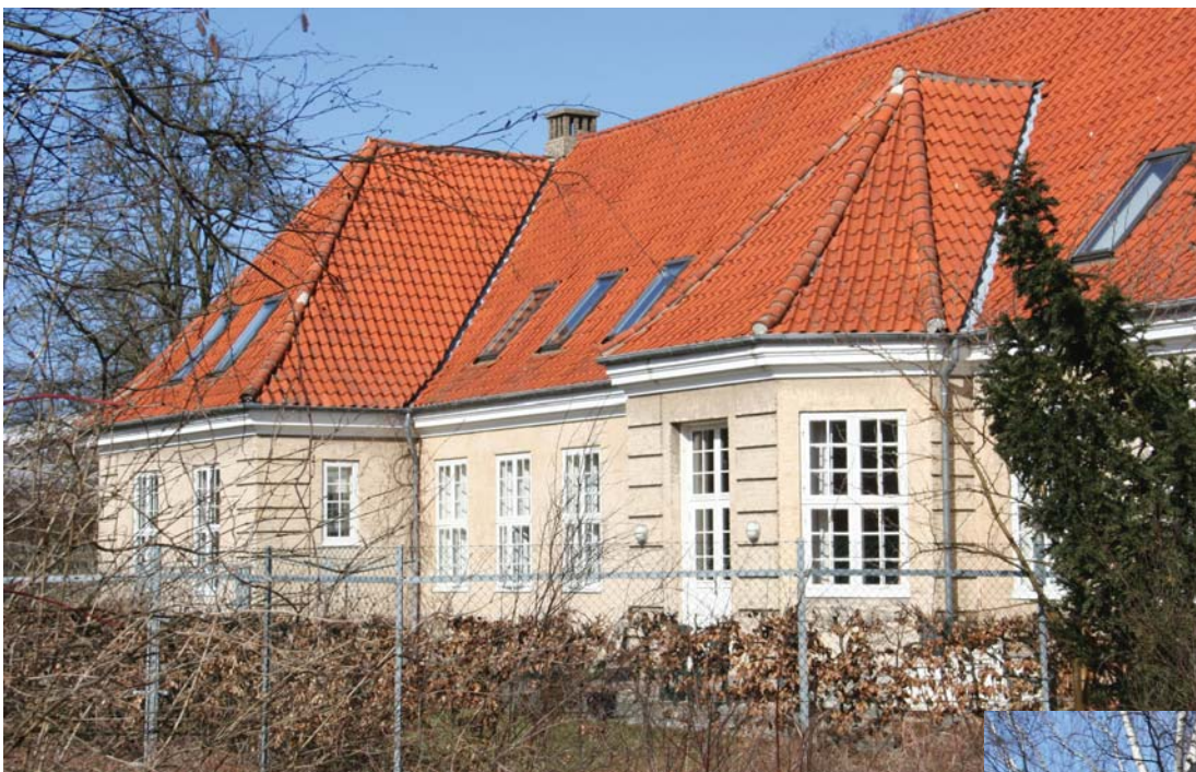
Lindehus, facade mod syd
