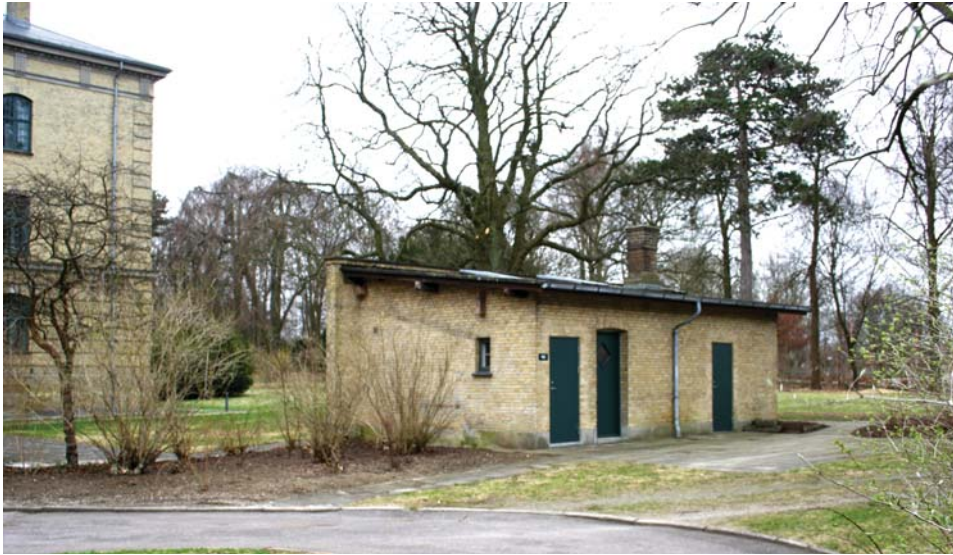
Værksteds- og toiletbygning, facade mod vest.
