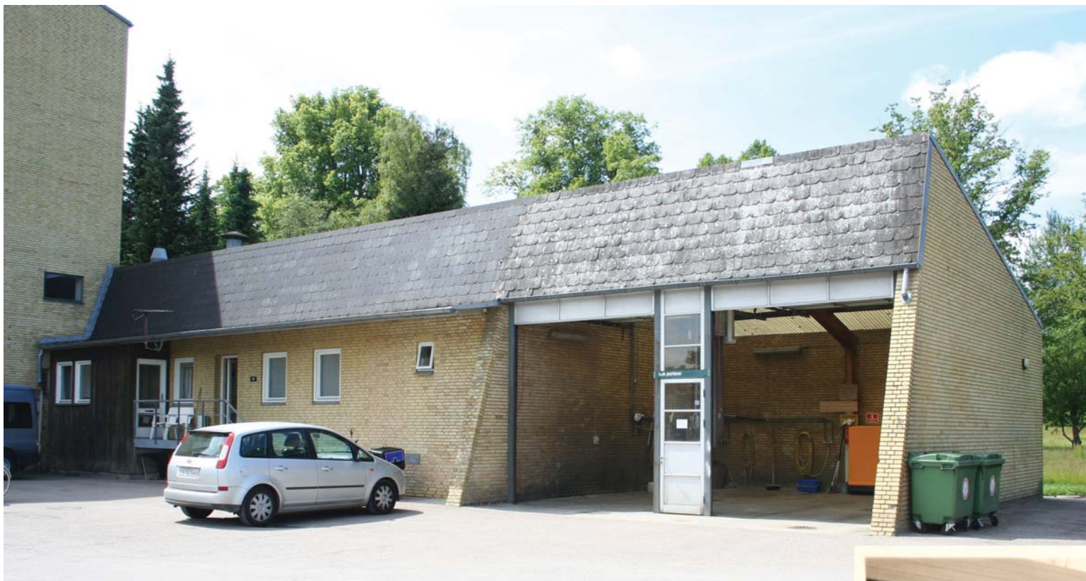
Portørcentral med folkerum, kontorer og bilvaskeanlæg
