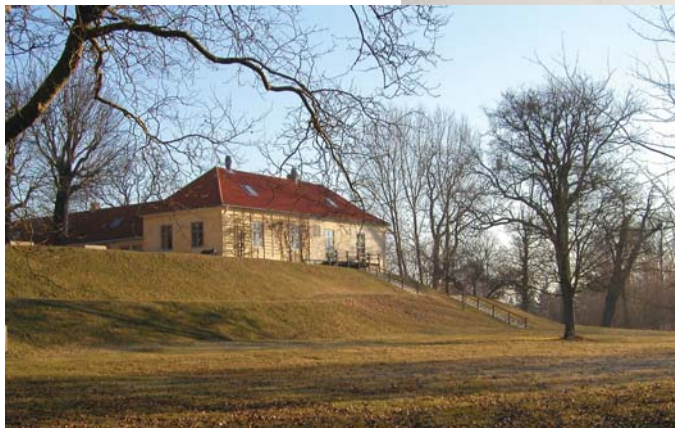
Slottets østfløj, Borgmesterlejlighed og forvalterbolig
