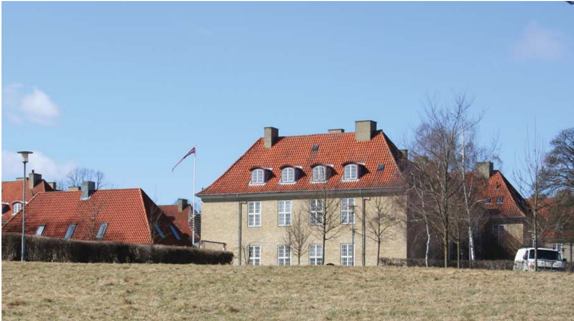
Poppelhus, facade mod øst
