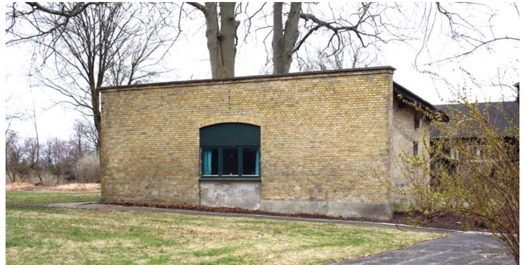
Værksteds- og toiletbygning, facade mod øst med tilmuret indgangsparti
