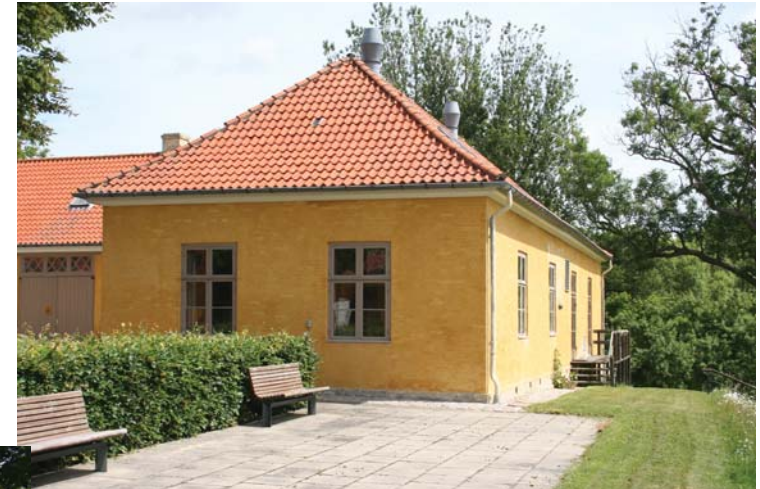
Slottets østfløj, borgmesterlejlighed og forvalterbolig
