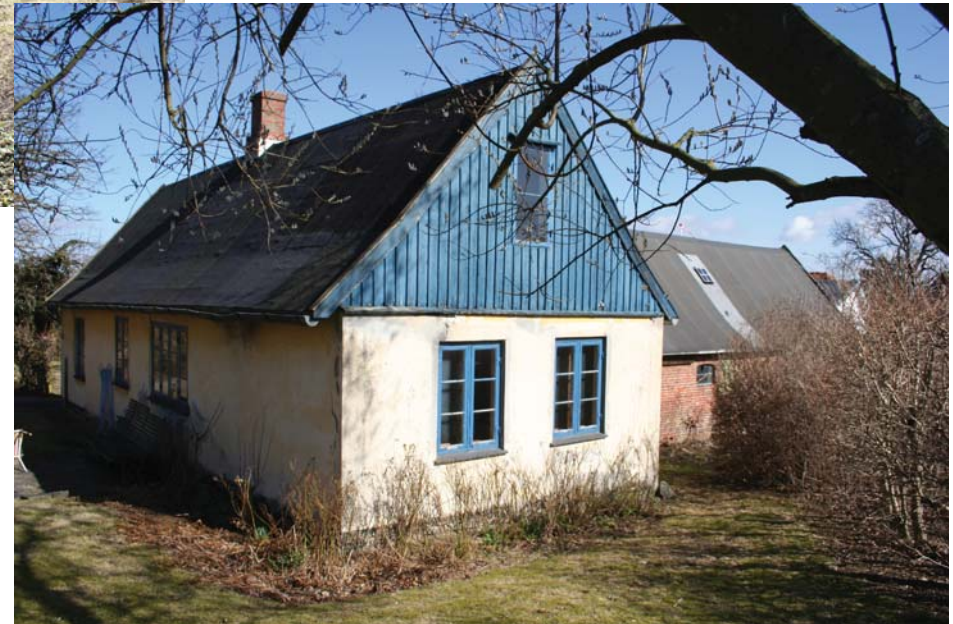
Wendtsgade 3, gavl mod syd
