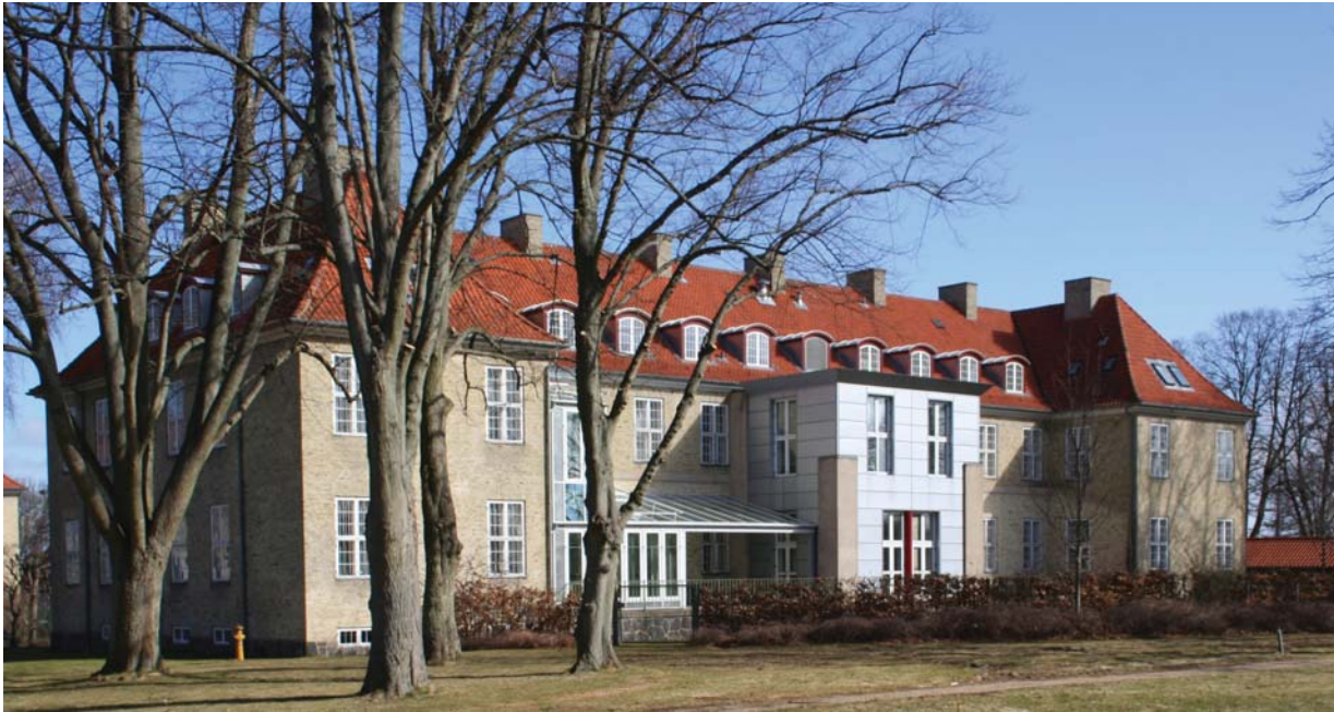
Toftehus, facade mod syd
