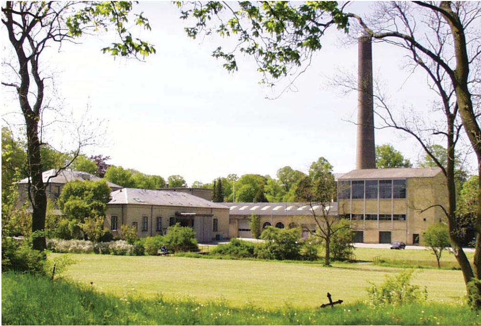
Maskinhuset m. kedelbygninger m.m. set fra øst
