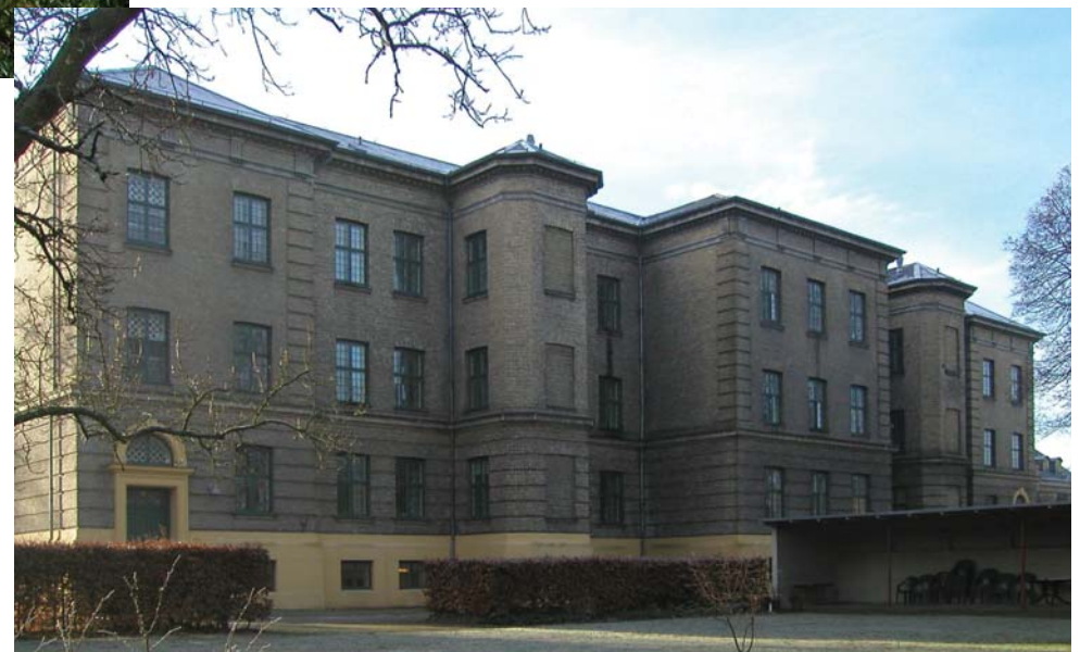
Platanhus, facade mod nord
