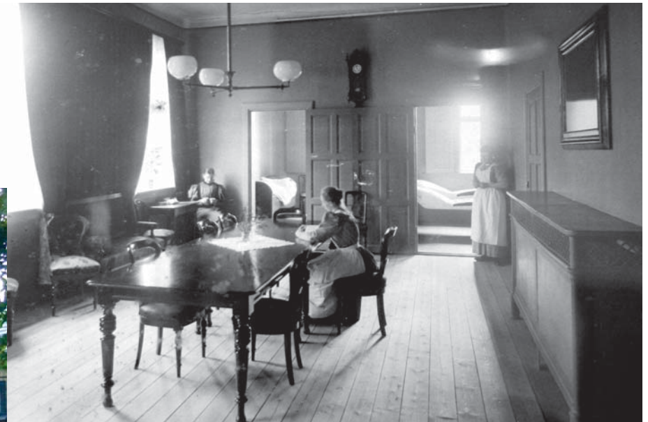
Kurhus B32 tilbygning ca 1910
