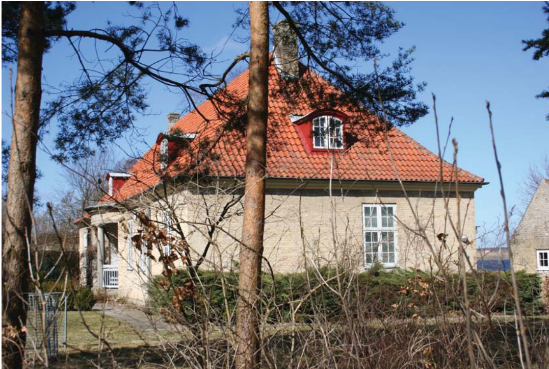
Toftebakken 11, gavl mod øst
