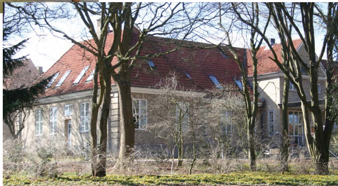
Elmehus, facade mod nord og øst
