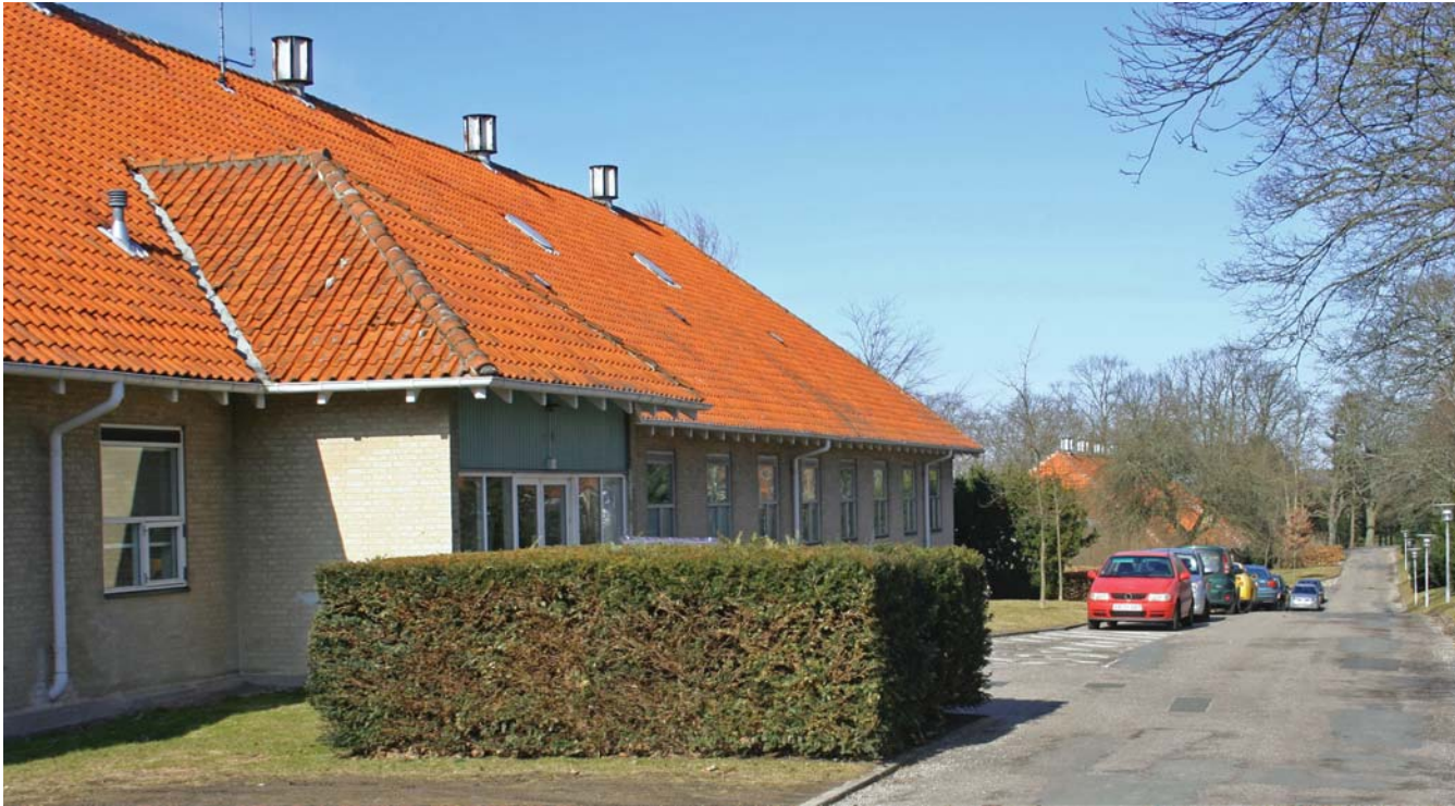
Solhus, østfacade med indgangsparti
