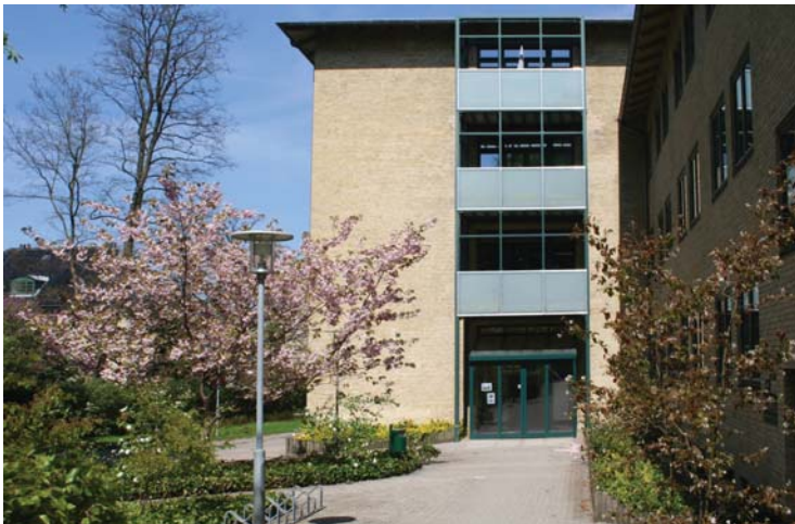
Indgangsparti ved oplysningskontor
