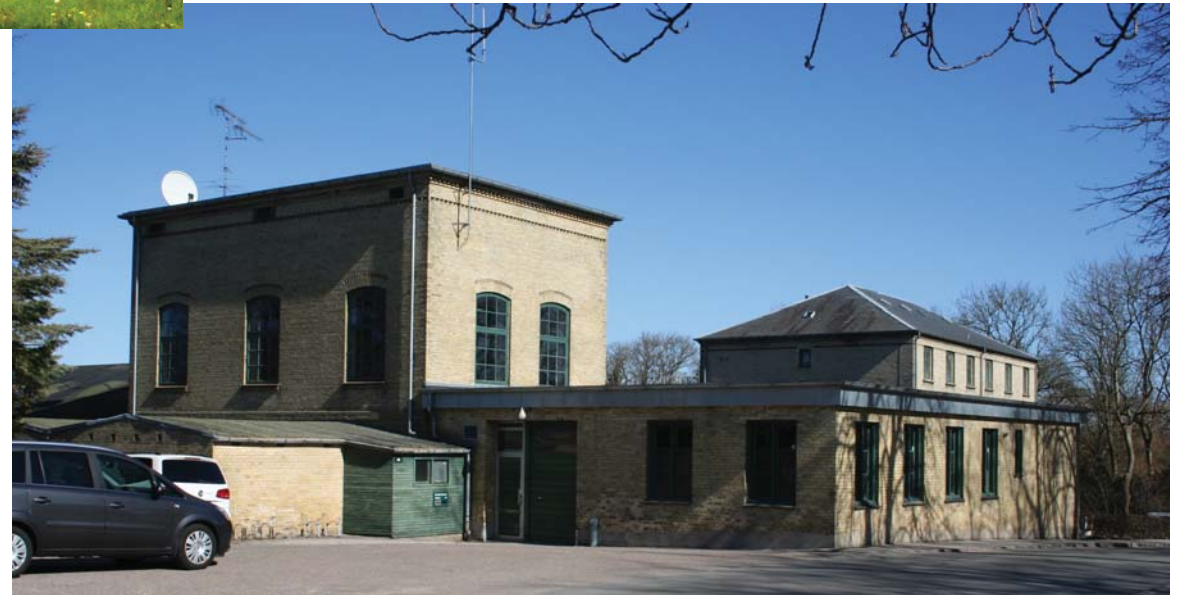
Maskinhuset m. elværksbygning m.m. set fra sydvest
