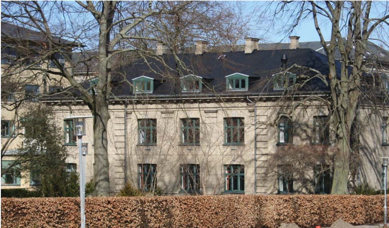
Udviklingsafdelingen / HB, sydfacade
