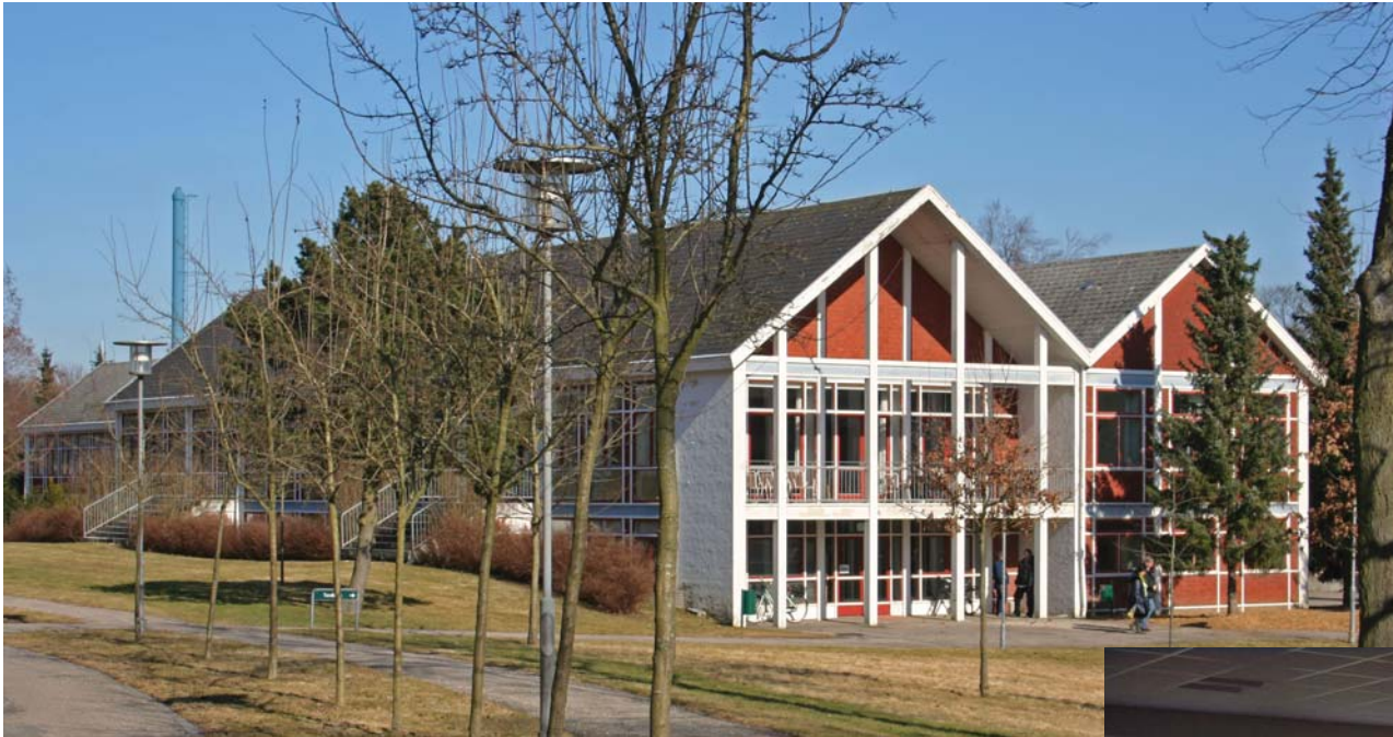
Centralkøkkenets gavl mod syd
