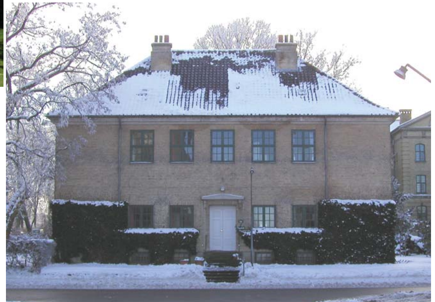
Heymanns hus, facade mod nord
