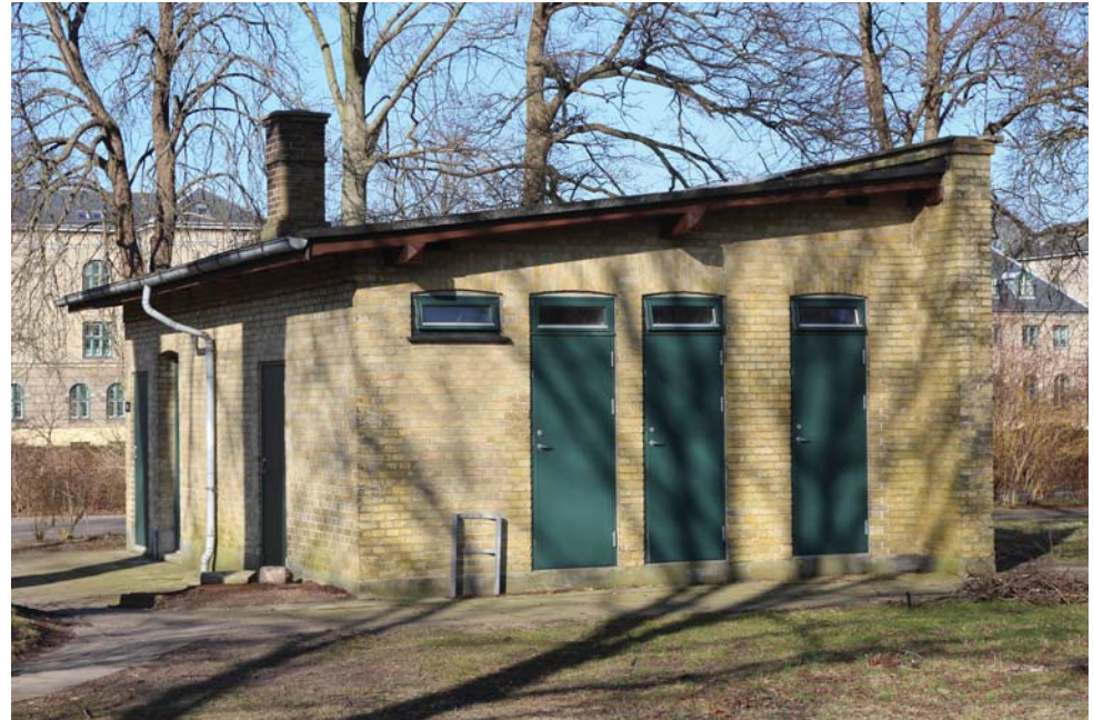
Værksteds- og toiletbygning, gavl mod syd.
